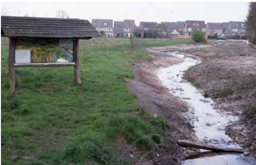
Herinrichting Drulse beek in 1994. In de voorheen kaarsrechte watergang kwamen kronkels en de taluds werden verflauwd. Achter in de boek ontstond een geplagd schiereilandje.
